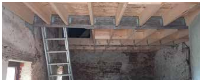
Aménagement d'un lieu de stockage pour le Patro de Havelange
